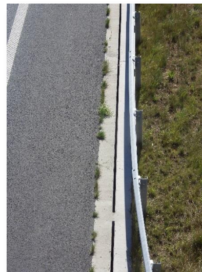
Photo 5 : Réseau latéral de collecte des eaux pluviales - Caniveau béton - PR26.12
