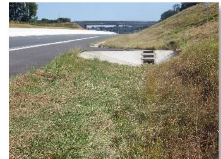
Photo 6 : Réseau latéral de collecte des eaux pluviales - Cunette dissymétrique - PR15.42
