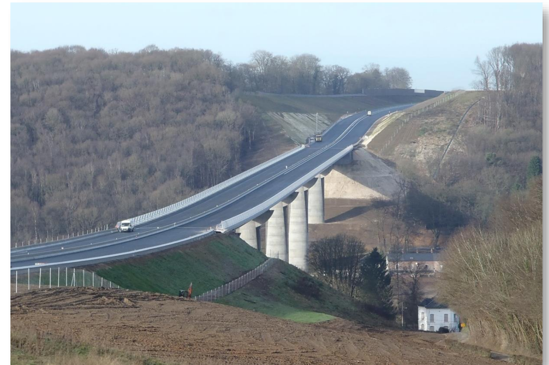
Photo 9 : Viaduc de l'Austreberthe (Photo Ingerop janvier 2015)
