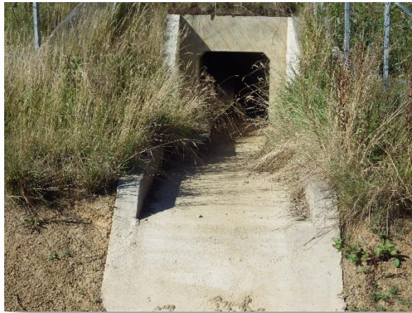
Photo 10 : Ouvrage hydraulique de type cadre béton – PR24.04 (Photo RBC Projet Août 2016)
