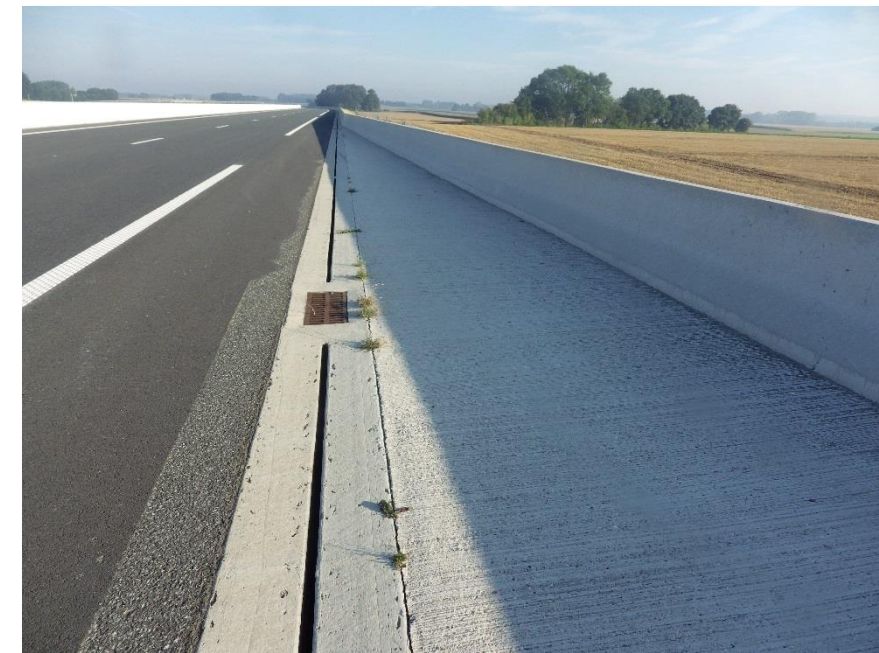
Photo 2 : Caniveau Béton dans la traversée du Captage de Limézy – PR24.52
