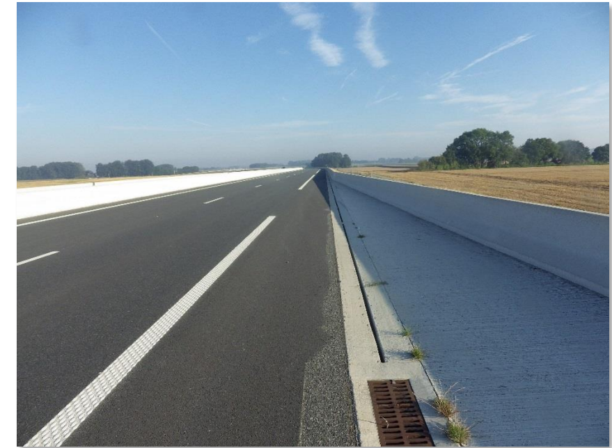
Photo 5 : GBA anti déversement sur la zone de traversée du périmètre de protection éloigné du captage de Limésy – PR24.52
