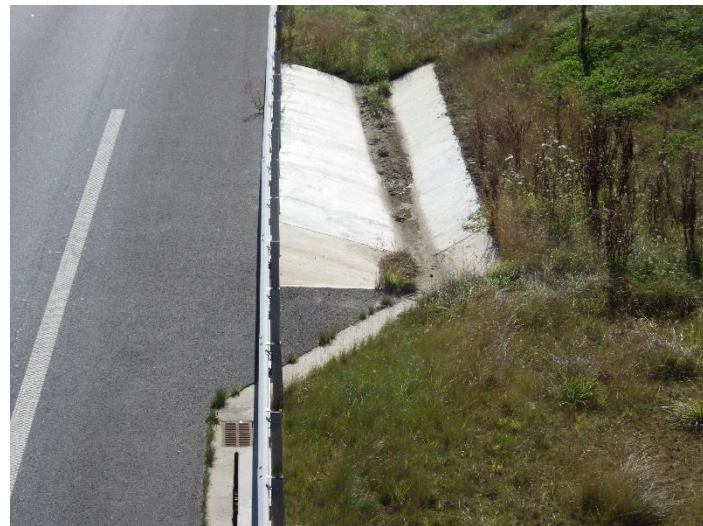
Photo 4 : Traitement du raccordement cunette / caniveau – PR15.42
