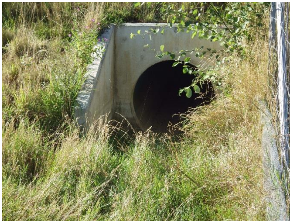
Photo 11 : Ouvrage hydraulique de type buse PEHD – PR26.78 (Photo RBC Projet Août 2016)
