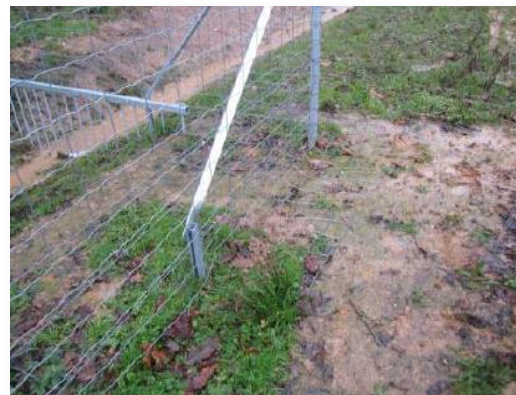
Photo 34 : Jambes de force (Photo RBC Projet Novembre 2015)
