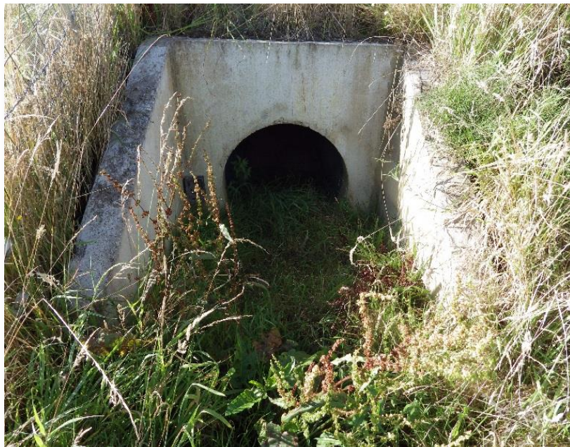
Photo 31 : PPF1900 – côté Ouest – PR26.78 – secteur du Bel Évent Flamanville (Photo RBC Projet Août 2016)
