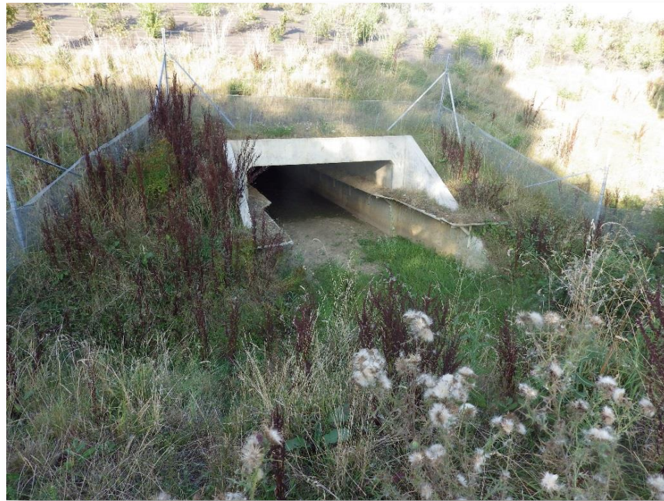
Photo 29 : Batrachoduc La Charrue côté Ouest PI1076 – Bouville – PR17.92 (Photo RBC Projet Août 2016)
