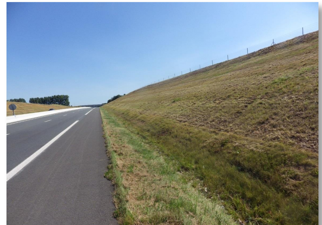
Photo 17 : Talus végétalisé et fauché – PR15.42 (Villers Ecalles) - Photo RBC PROJET Août 2016
