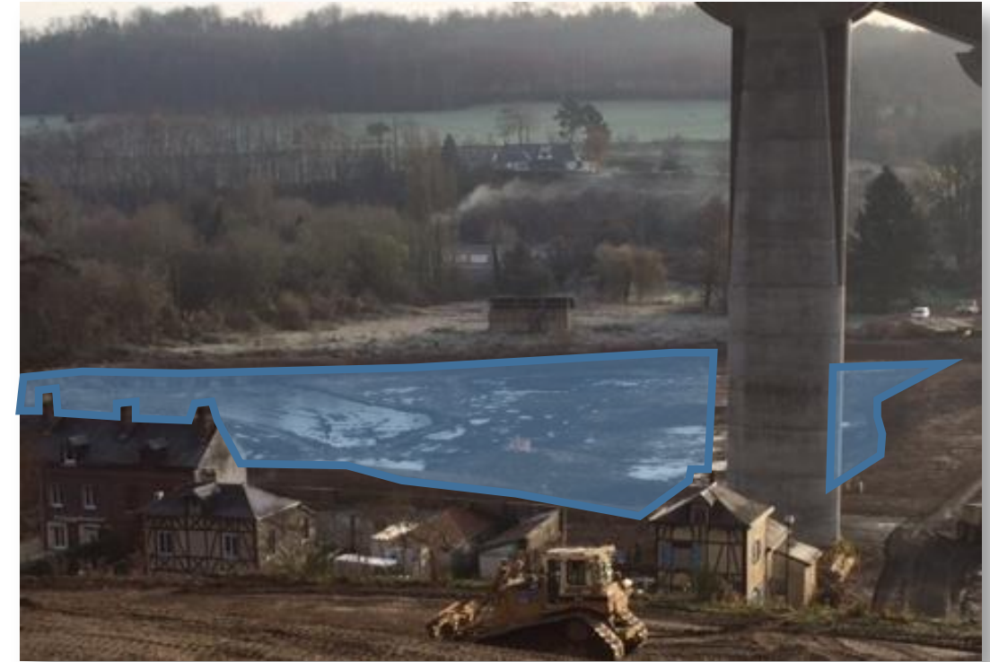
Photo 21 : Zone Humide de l'Austreberthe terrassée – Barentin (Mars 2015) – PR14.18 – Photo INGEROP
