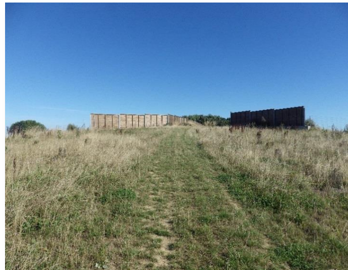
Photo 25 : PGF Flamanville – PR26.60 zone d'approche Ouest (Photo RBC Projet Août 2016)
