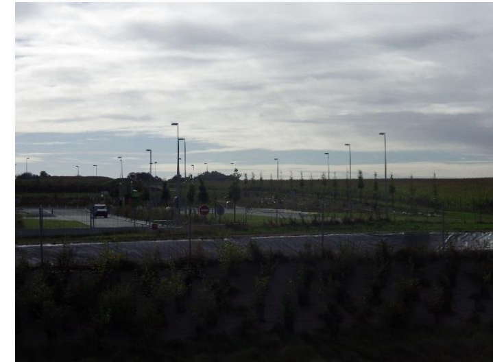
Photo 45 : Éclairage halte simple - PR15.88 (Photo RBC Projet septembre 2016)
