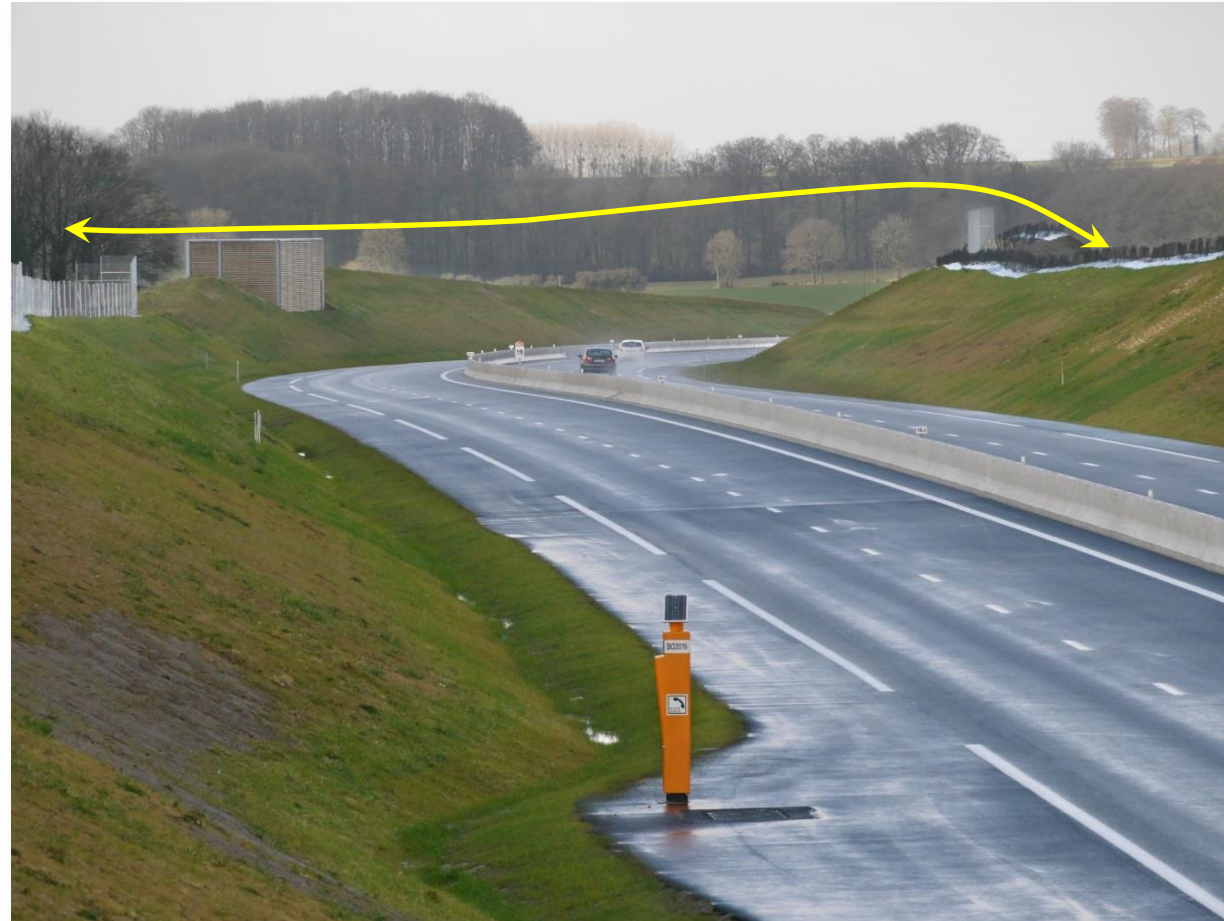
Photo 38 : Hop Over à Boscriscard (Bouville) – PR19.20 – (Photo INGEROP Octobre 2014)
