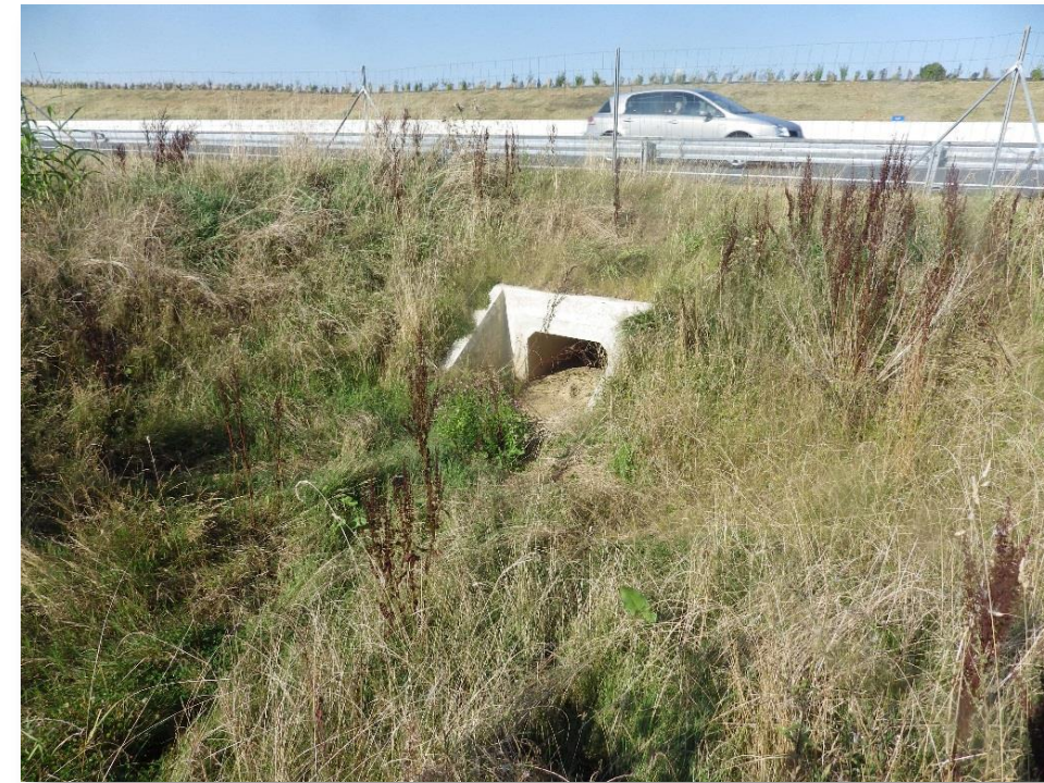
Photo 30 : Batrachoduc Courvaudon côté Ouest PPH13620 – Villers Ecalles – PR15.06 (Photo RBC Projet Août 2016)
