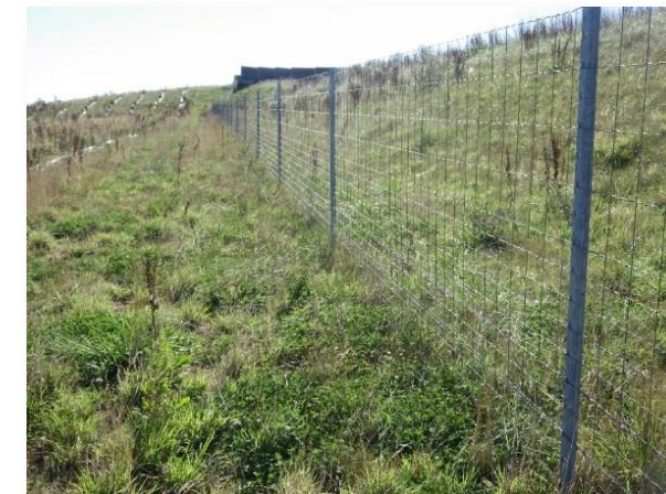
Photo 35 : Clôture Grande faune à mailles progressives – PR26,76 (Photo RBC PROJET Août 2016)
