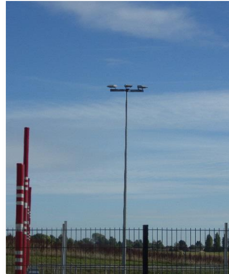
Photo 44 : Mat lampadaire section courante BPV - PR16.08 (Photo RBC Projet septembre 2016)
