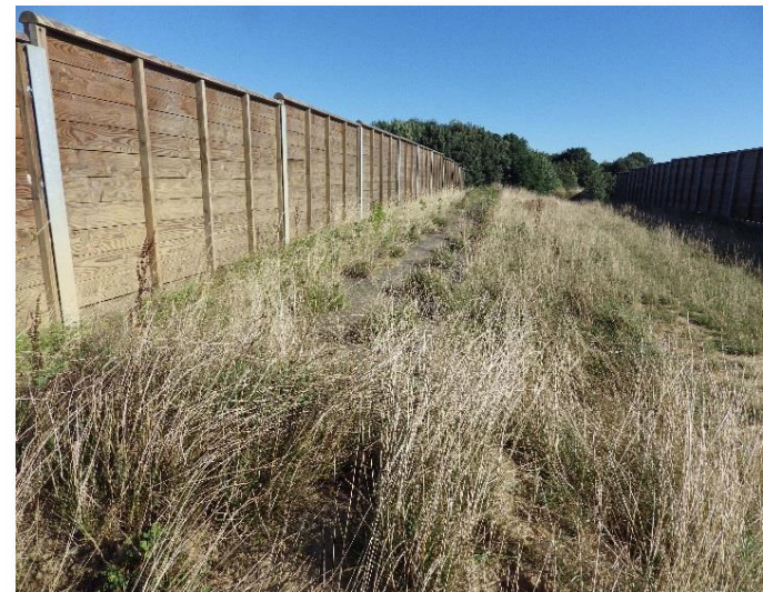
Photo 26 : PGF Flamanville – PR26.60 zone de franchissement (Photo RBC Projet Août 2016)
