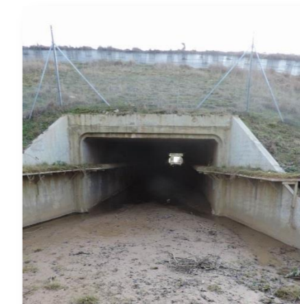
Photo 121 : PPF 1078 - La Charrue Passage inférieur
