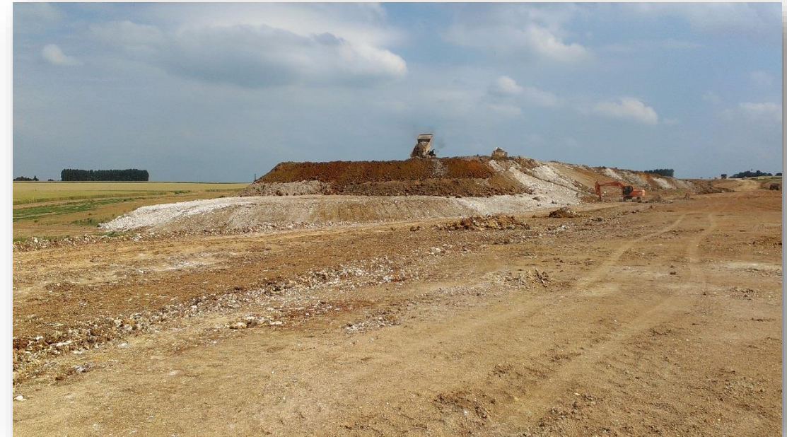
Photo 225 : Dépôt provisoire de matériaux servant à la couche de forme- Bouville (Photo RBC PROJET Juillet 2013)
