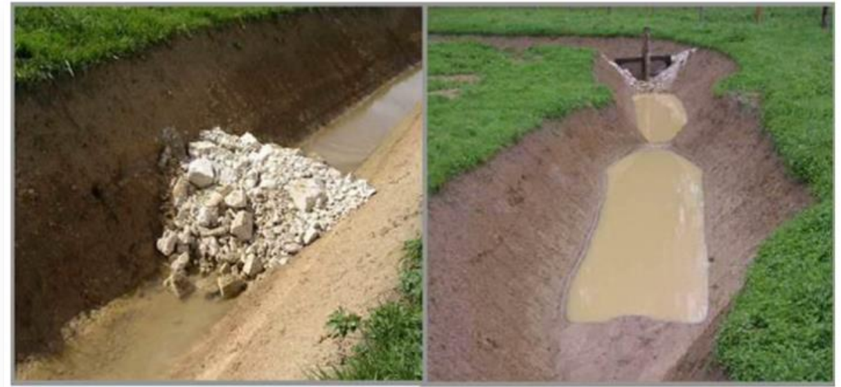
Photo 211 : À gauche, fossé amont aménagé avec des seuils en cailloux pour casser l'énergie et limiter les phénomènes érosifs par réduction des vitesses instantanées. À droite : blocage en caillou du filtre à fines
