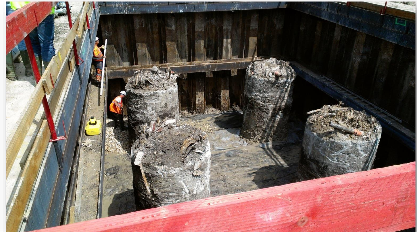
Photo 229 : Batardeau pour la réalisation des fondations par pieux forés à sec de la pile P3 du viaduc de l'Austreberthe (Photo RBC PROJET – Juillet 2013)
