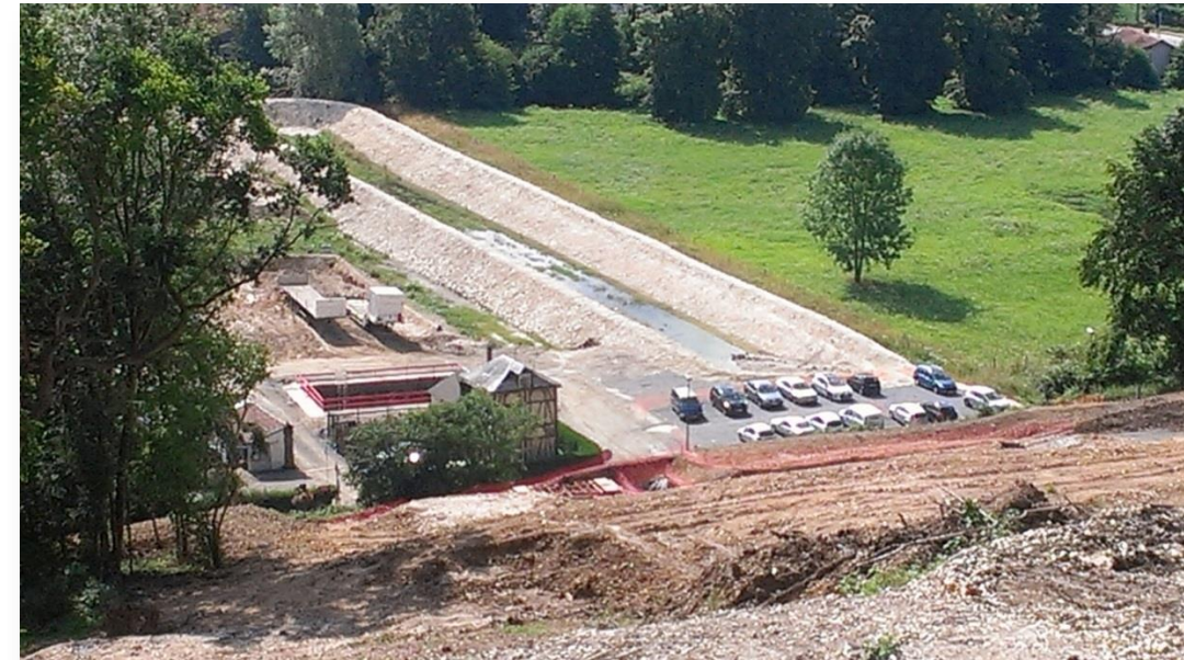
Photo 198 : Bassin assurant la gestion des eaux de la piste de chantier en fond de vallée de l'Austreberthe (Août 2013 – Photo RBC Projet)
