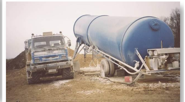
Photo 105 : organisation d'une station de traitement à la chaux
