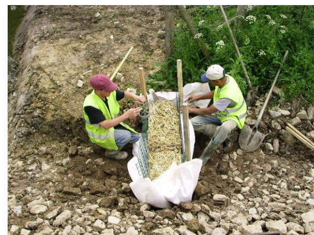
Photo 212 : Installation d'un filtre à paille
