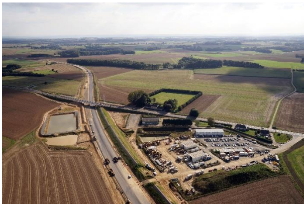
Photo 202 : Installation de chantier de Mesnil Panneville
