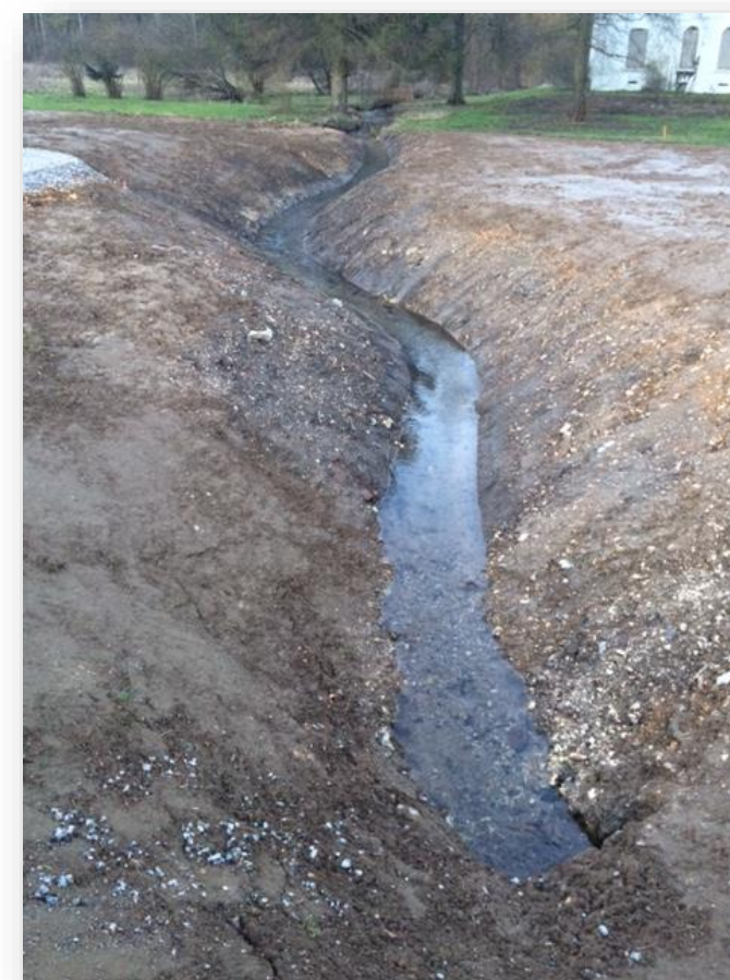
Photo 227 : Remise à l'air libre et reconstitution d'un lit naturel de la source rive gauche à la fin des travaux de construction du viaduc de l'Austreberthe (Photo INGEROP – Février 2015)
