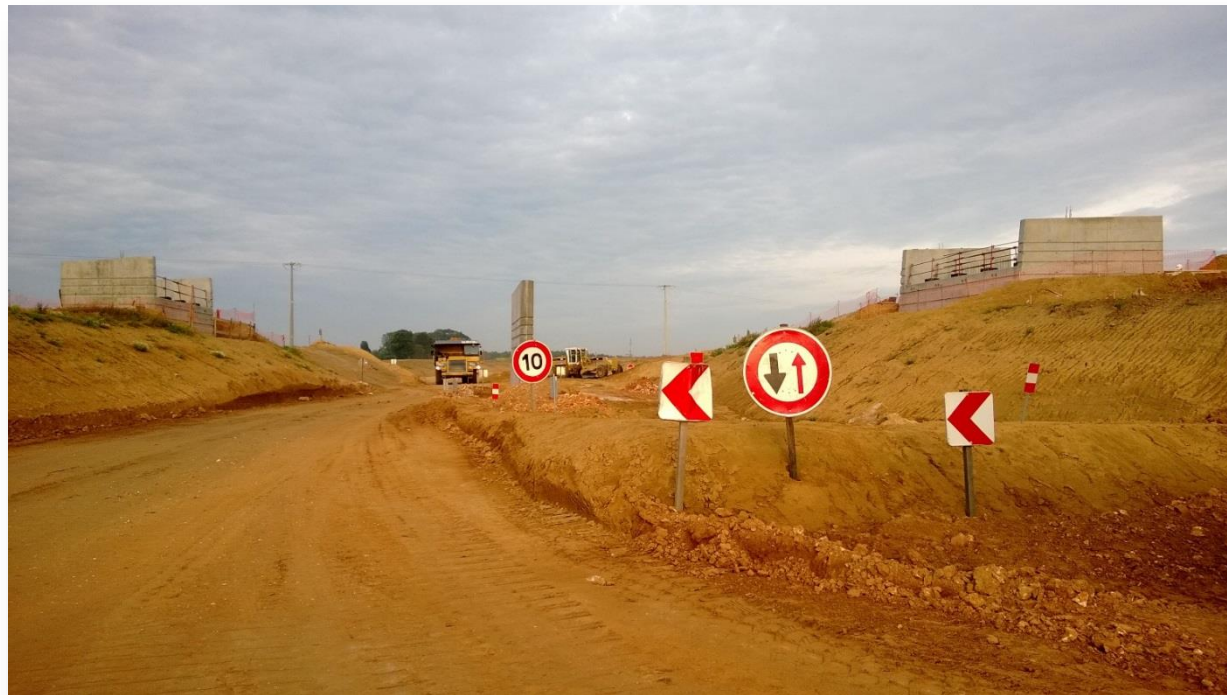
Photo 208 : Signalisation adaptée pour la circulation des engins et des transports d’approvisionnement du chantier.
