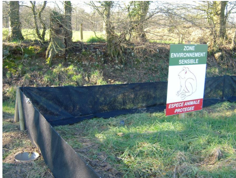
Photo 203 : Filet à batracien empêchant l'accès à l'emprise travaux et seuil de collecte des batraciens pour transfert vers mare voisine. (Photo OGE)
