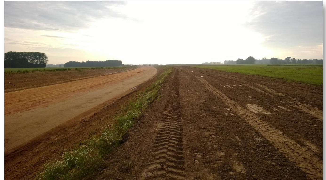
Photo 209 : Remise en état des terrains empruntés pour la circulation pendant le chantier (partie gauche de la photo) et restitution à l’agriculture (la teinte brune de la terre correspond à la terre végétale remise en place dans le cadre de la remise en culture)
