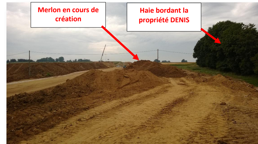
Photo 221 : Merlon en cours de création au début des opérations de terrassement – La Charrue (Bouville) – PR18.06
