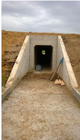
Photo 218 : Cadre béton en cours de pose (OHA5642) – PR23.05
