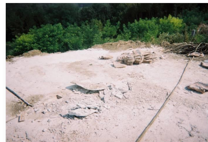
Photo 201 : Exemple de déchets de chantiers qui feront l'objet d'une collecte sélective
