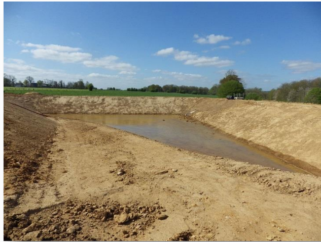
Photo 201 : Exemple de bassin provisoire réalisé au début des travaux de terrassements
