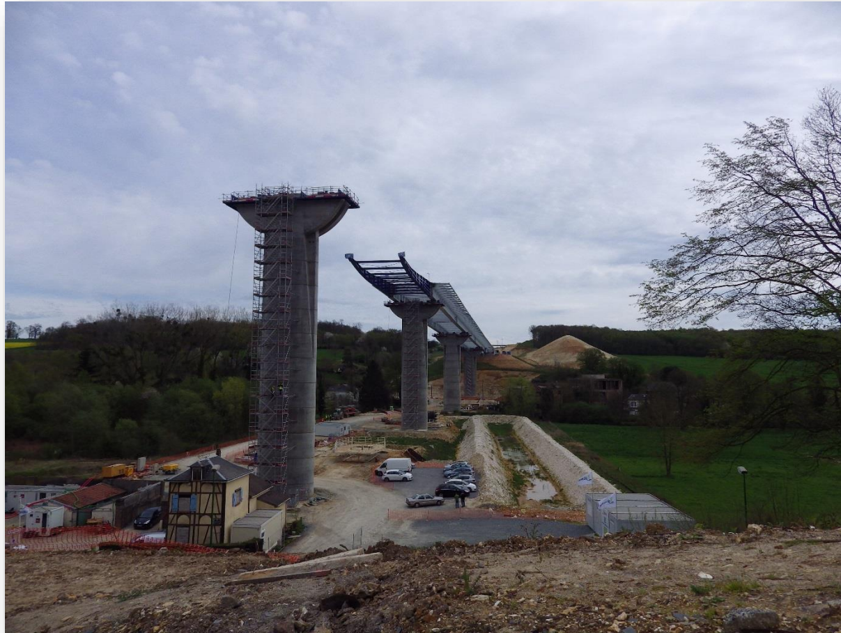
Photo 228 : Piste de chantier en fond de vallée de l'Austreberthe
