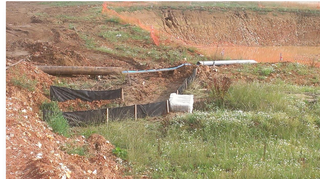
Photo 197 : Bassin provisoire sur le secteur du Bois de Sap à Mesnil Panneville (Août 2013 – Photo RBC Projet)
