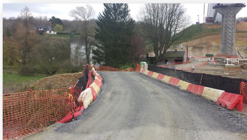
Photo 226 : Pont provisoire permettant le franchissement de l'Austreberthe (Photo INGEROP – février 2014)
