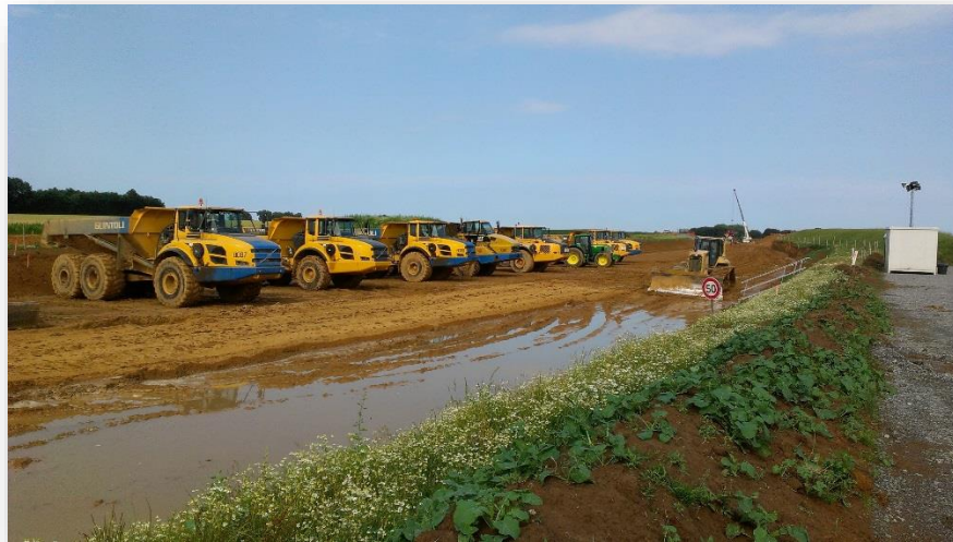
Photo 224 : Zone de stationnement des engins de chantier à l'écart des habitations – Motteville (Photo RBC Projet – Juillet 2013)
