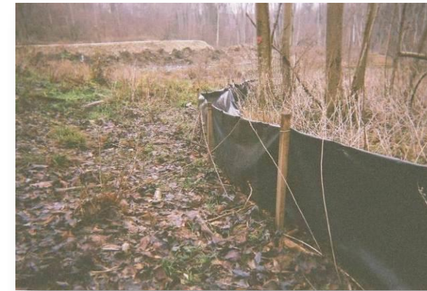
Photo 217 : Exemple de dispositif empêchant l'accès des batraciens aux emprises de travaux en phase chantier
