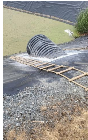
Figure 2 : Reconstruction de l'ouvrage d'entrée du bassin BM13.7
