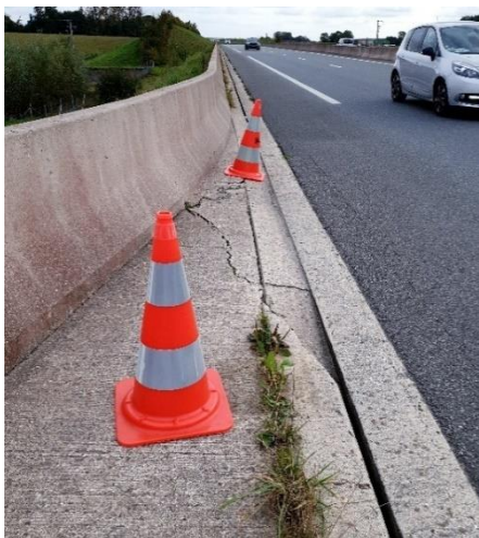
Figure 3 : Reconstruction du caniveau à fente
