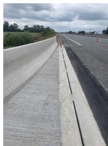
Figure 3 : Reconstruction du caniveau à fente
