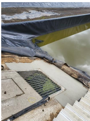
Figure 2 : Réparation de l'étanchéité du bassin BM11.9
